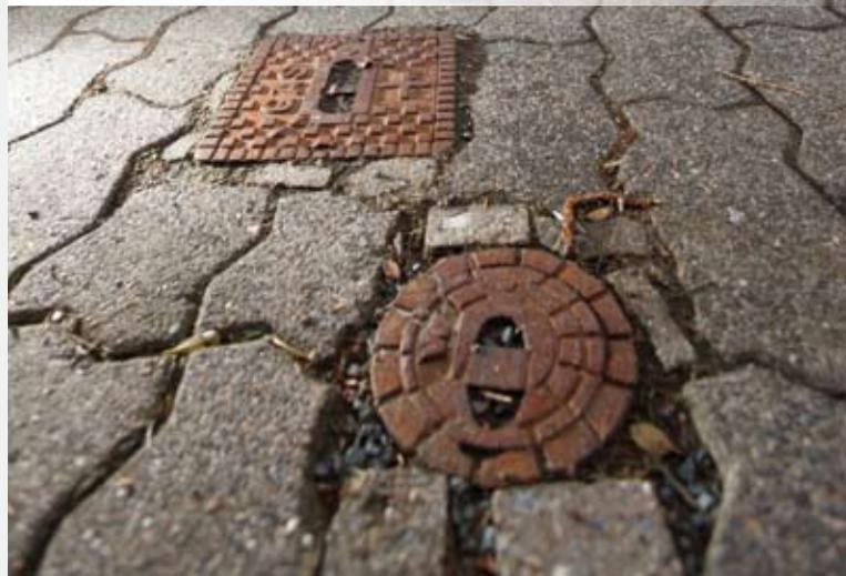
Häuser werden über unterirdische Leitungen mit Trinkwasser und Energie versorgt. Diese Leitungen müssen zugänglich sein, um bei eventuellen Problemen umgehend reagieren zu können. Dies ist nicht möglich, wenn Hausanschlüsse überbaut wurden, zum Beispiel durch Wintergärten oder Garagen.
